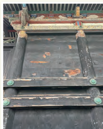
本殿裏の漆塗り(塗装)が剥げ、欠落
