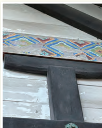
本殿裏の漆塗り(塗装)が剥げ、欠落
